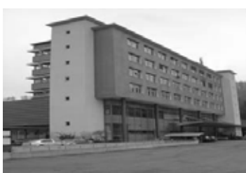
Gewerbebau Schlachthofstrasse 19 Winterthur Töss
