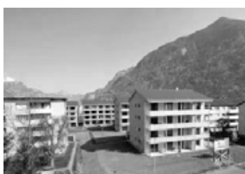
Wohnüberbauung Steinmattstrasse 27a/b, 29a/b, 37, 39 Altdorf
